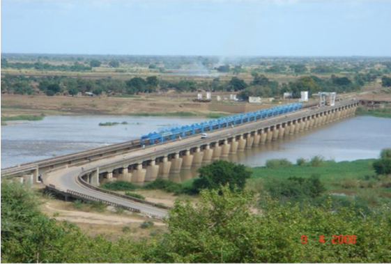
Mozambik Macarretane Rehabilitasyon Projesi
